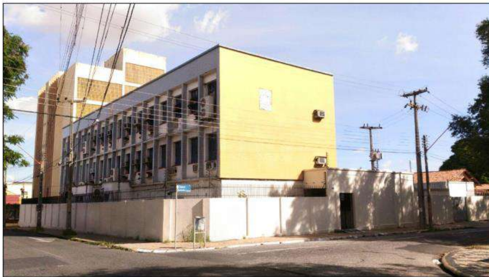
Figura 2 – Fachada do prédio do CEAD – Sede
